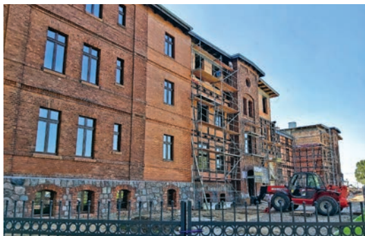
Na terenie dawnego obozu rozpoczęły się prace budowlane
